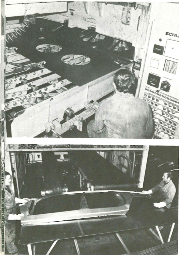
◀ Le panneau de côté de la CX est terminé.
