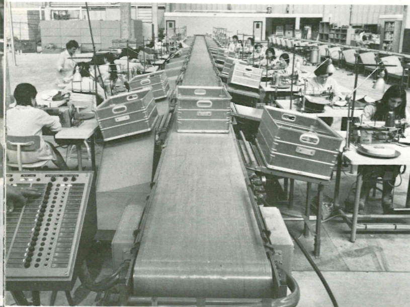
L'une des deux lignes de piquage : elle est conçue pour éviter aux piqueuses de se déplacer et leur permettre de travailler à leur rythme.
